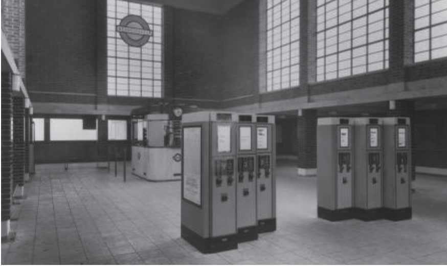
Resim 6: İstasyon girişi, Northfields, 1933.
